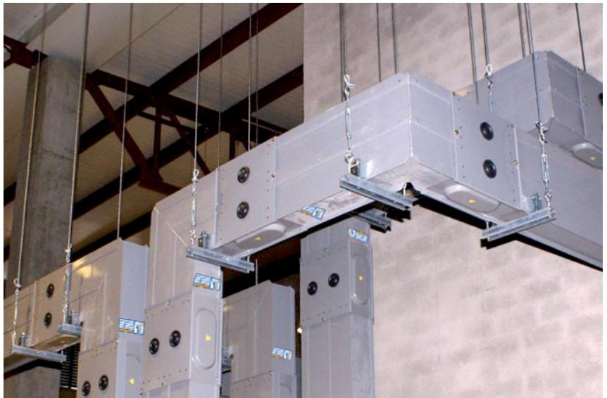
Die Niederspannungsstromschiene "IMPACT" ist sowohl für den Energietransport als auch für die Energieverteilung geeignet und findet als Verbindung zwischen Trafo und Niederspannungshauptschaltanlagen sowie zwischen den Hauptschaltanlagen und den Unterverteilungen in der Industrie, im Gewerbe und in der Dienstleistung Anwendung.
